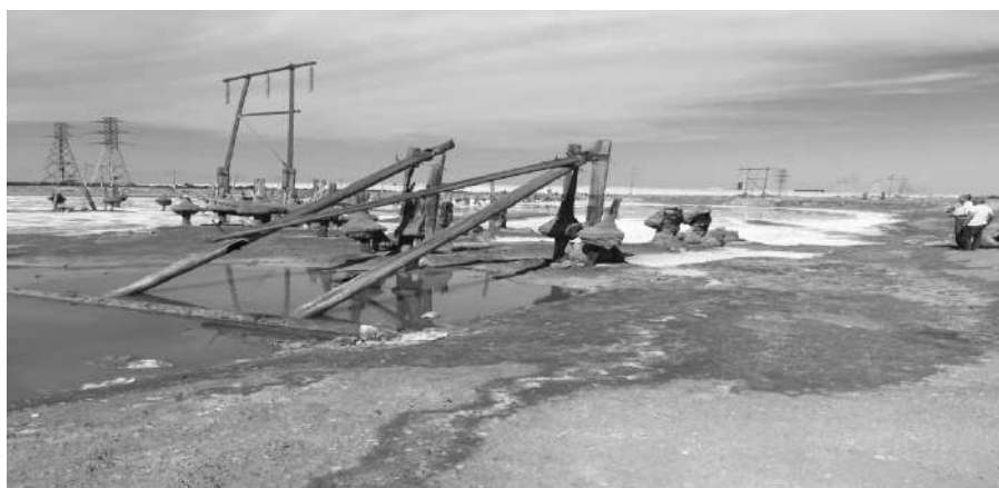
Şəkil 2. Keçmiş Yod-brom zavodunun qalıqları
