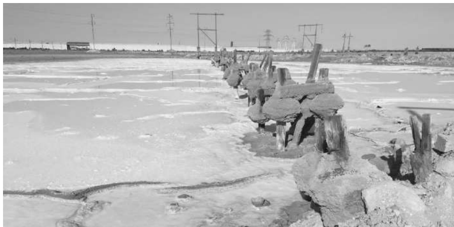
Şəkil 1. Keçmiş Yod-brom zavodunun qalıqları
