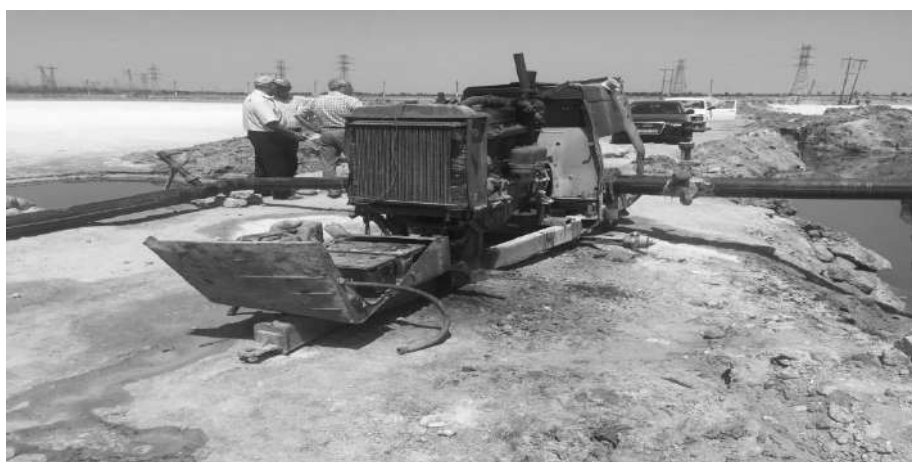
Şəkil 3. Köhnə Yod-brom zavodu ərazisindən səyyari nasosla duzlu suyun Hövsan kanalına vurulması
